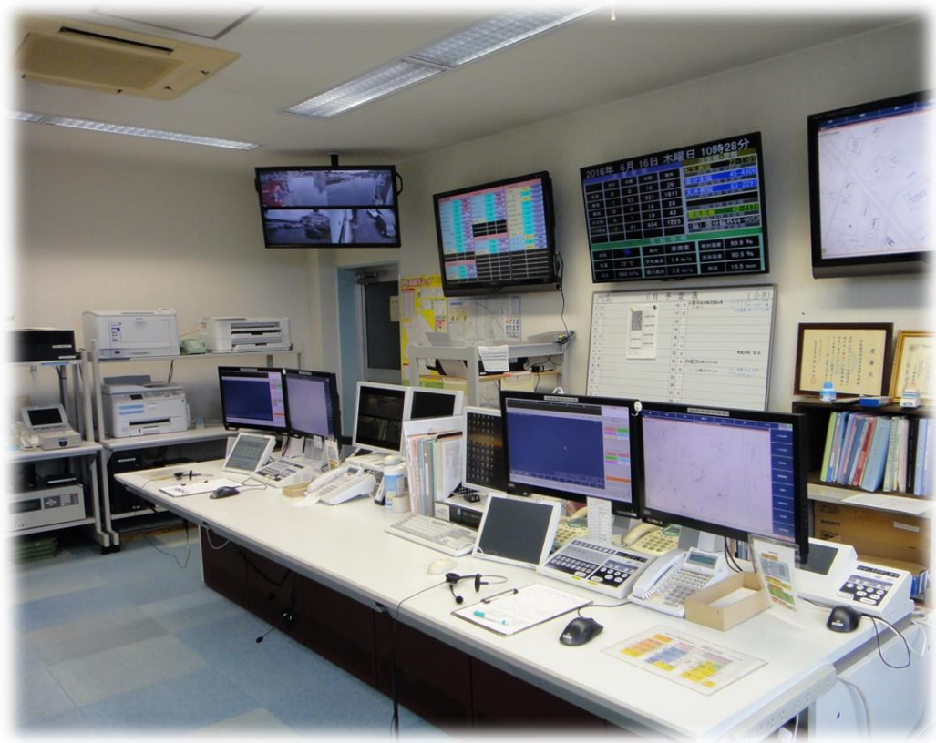
伊佐湧水消防組合消防本部 通信指令室
