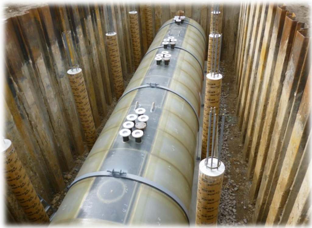
地下タンク貯蔵所
